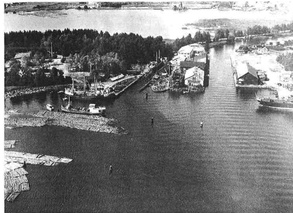
Vy över varvet, 30- eller 40-tal? Till höger vid inloppet till Inre hamnen ses Järnvägen som revs 1957. Till vänster om inloppet brevid den ljusa byggnaden ses ett fartyg under nybyggnad på badden. Därefter ses ett fartyg under reparation uppdraget på släpen. Till vänster om släpen ligger ett par fartyg sidoförtöjda vid utrustningskajen. Foto: Värmlands museum.
