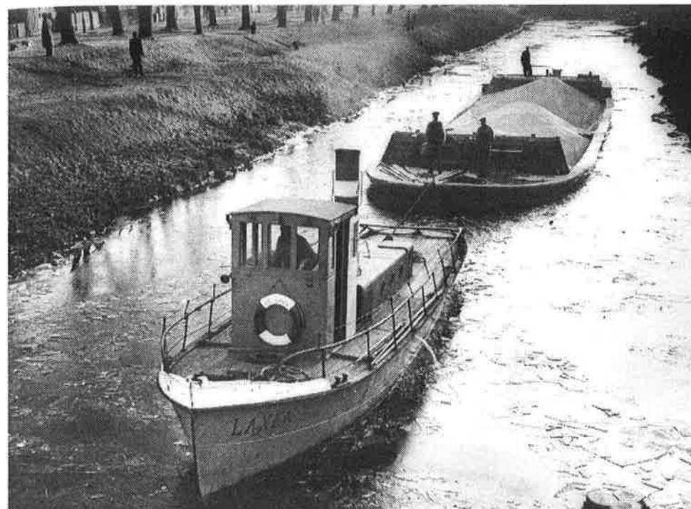
Bogserbåten Laxen på väg i Pråmkanalen med destination Forshaga. Pråmen är lastad med svavel som intagits från ett större fartyg i Yttre hamnen. Foto: N Almgren, VF.
